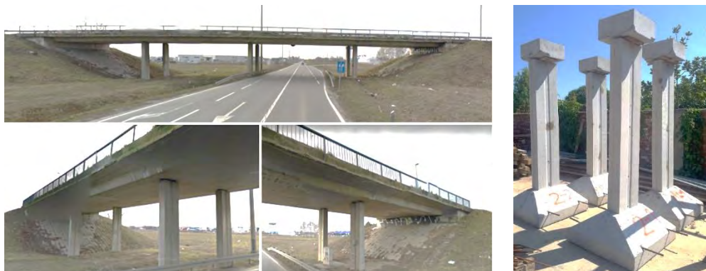
Slika 1. Odabrani stup nadvožnjaka (lijevo) i izvedeni eksperimentalni stupovi (desno)
